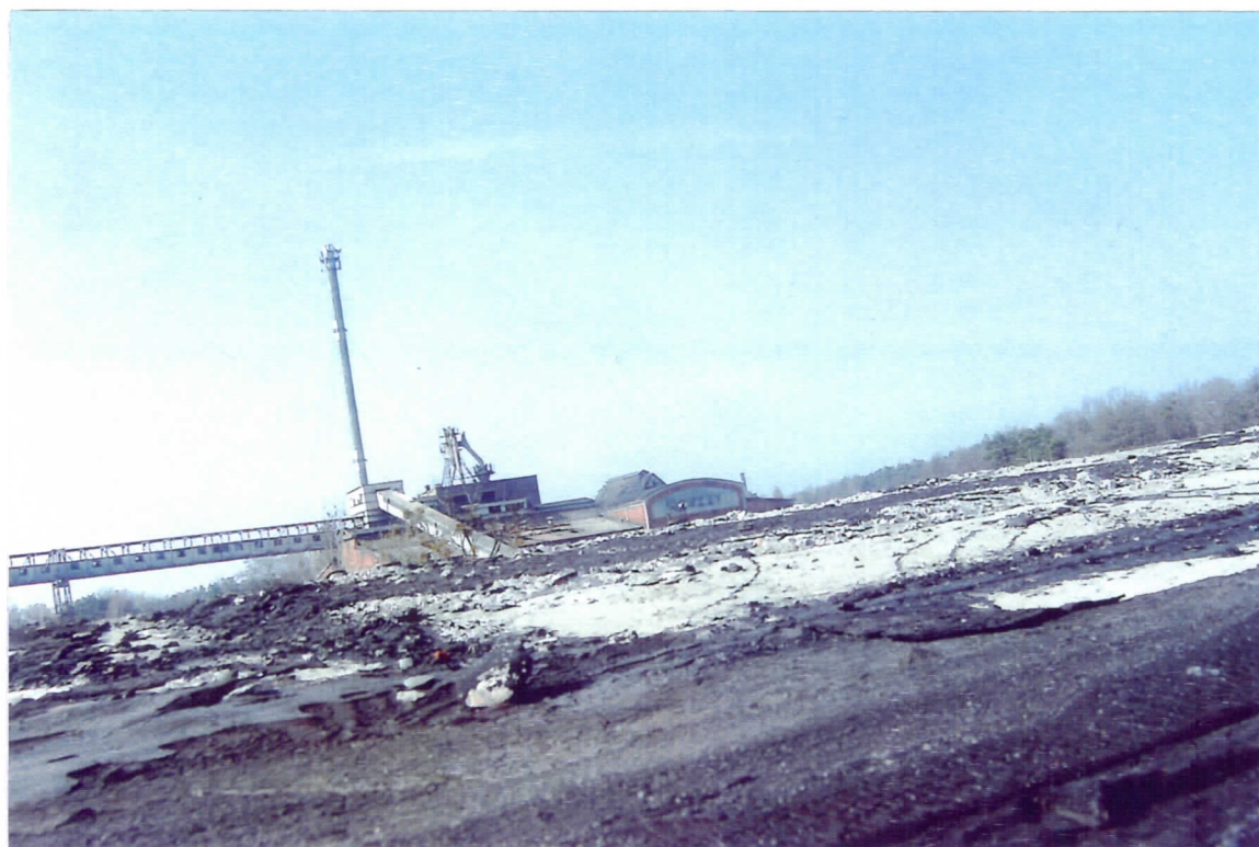
Rys 12 Widok pokrycia dachu hali 2 . Widoczne całkowite zniszczenie pokrycia dachu.
