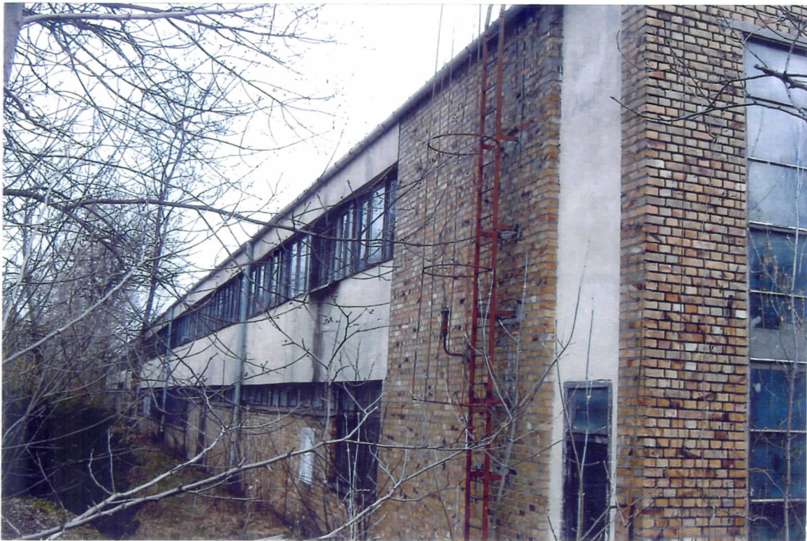
Rys 6 Widok zewnętrznej ściany północnej w osiach budynku biurowego.
