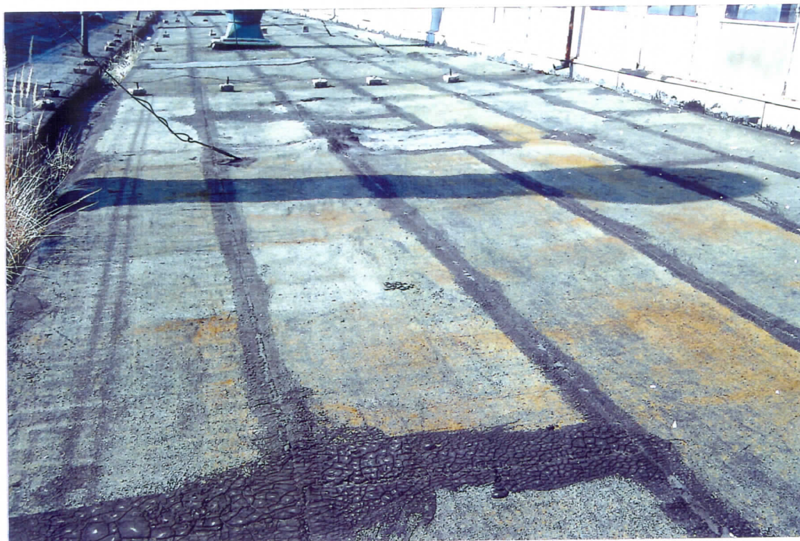
Rys 11 Widok pokrycia dachu hali 1.
