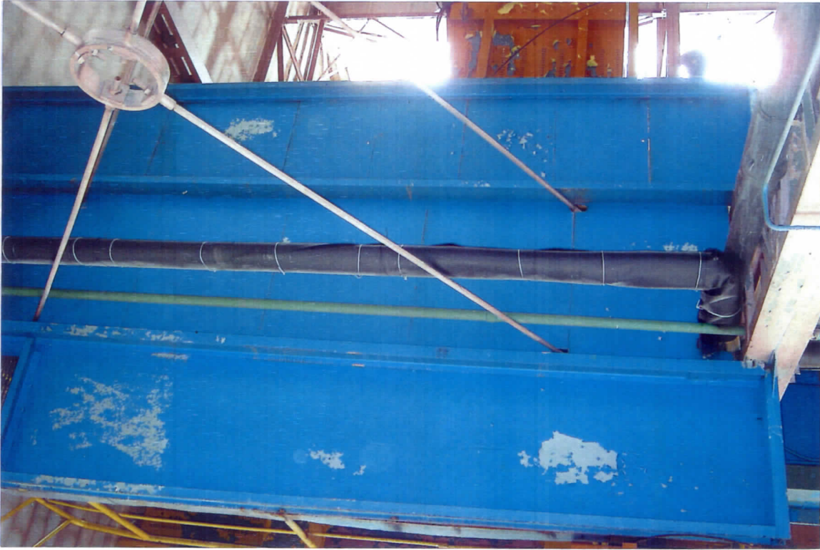
Rys 25 Stężenie pionowe hali 1.
