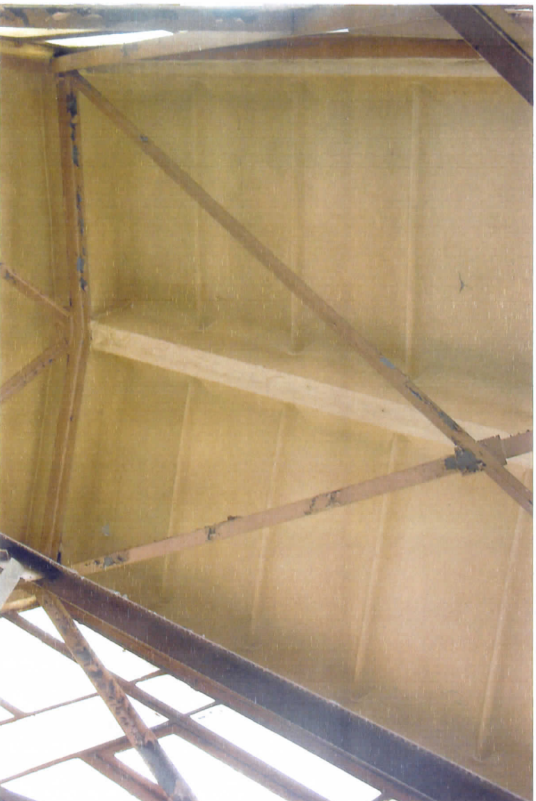
Rys 22 Stężenia połaciowe hali 1.
