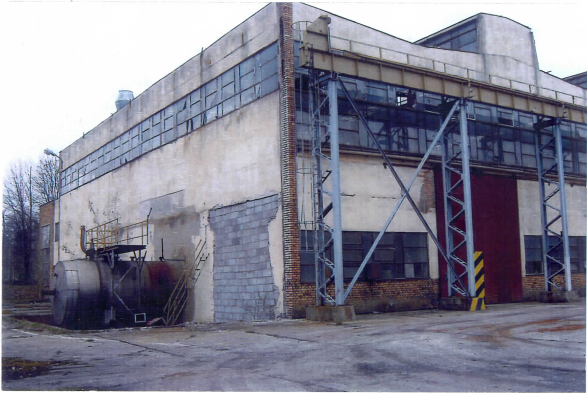
Rys 5 Widok narożnika zewnętrznej ściany zachodniej i południowej w osi 1.
