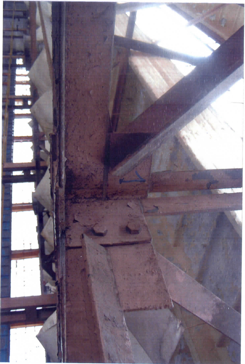
Rys 31 Węzeł podporowy wiązara hali 1.
