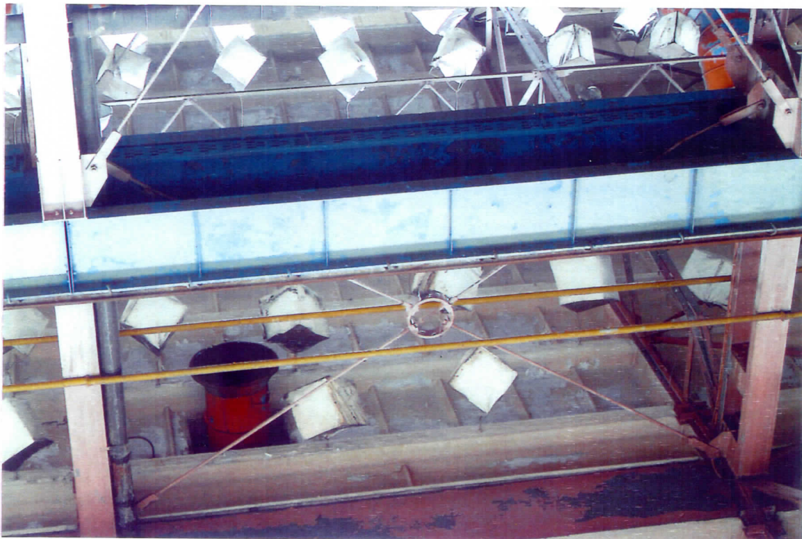
Rys 24 Belka podsuwnicowa hali 1.
