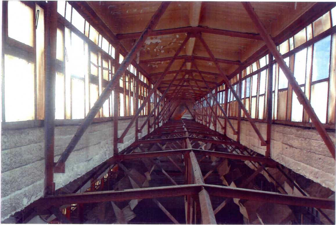
Rys 23 Konstrukcja świetlika hali 1.
