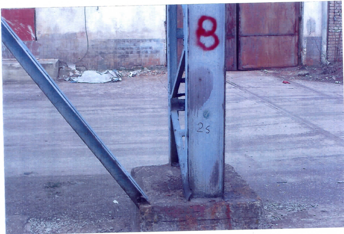
Rys 55 Stężenie słupów estakady.
