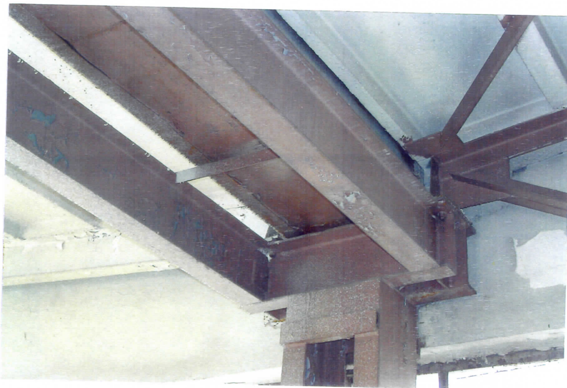
Rys 18 Podparcie wiązara skrajnego Hali 2 w osi 2.
