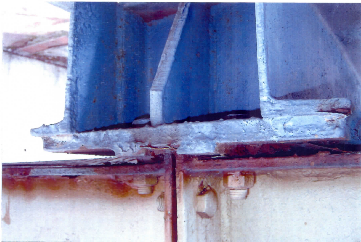
Rys 49 Szczegół podparcia belki podsuwnicowej na estakadzie.
