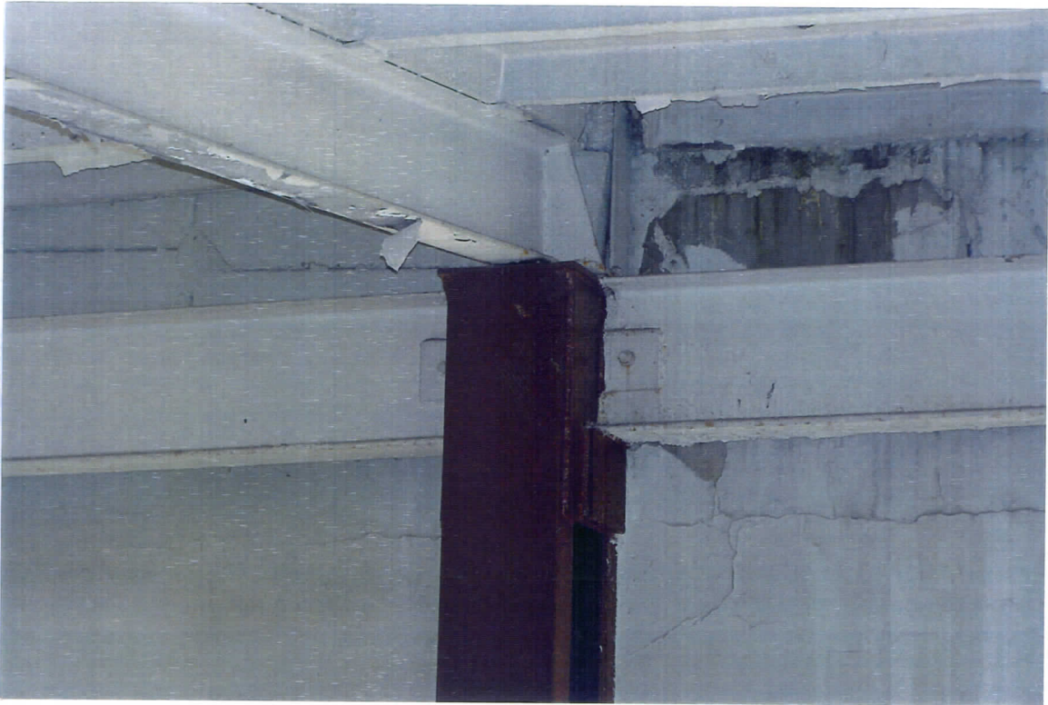
Rys 19 Podparcie podciągów dachowych Hali 2 w osi 1.
