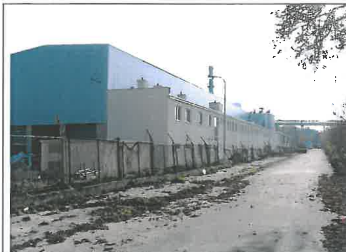
1. Widok ogólny od ul. Przemysłowej
