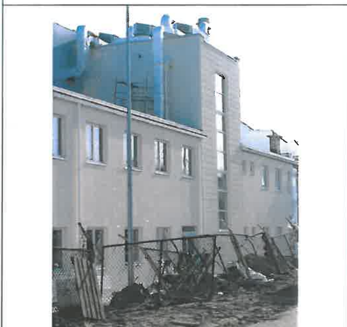
3. Widok ogólny od ul. Przemysłowej – klatka centralna
