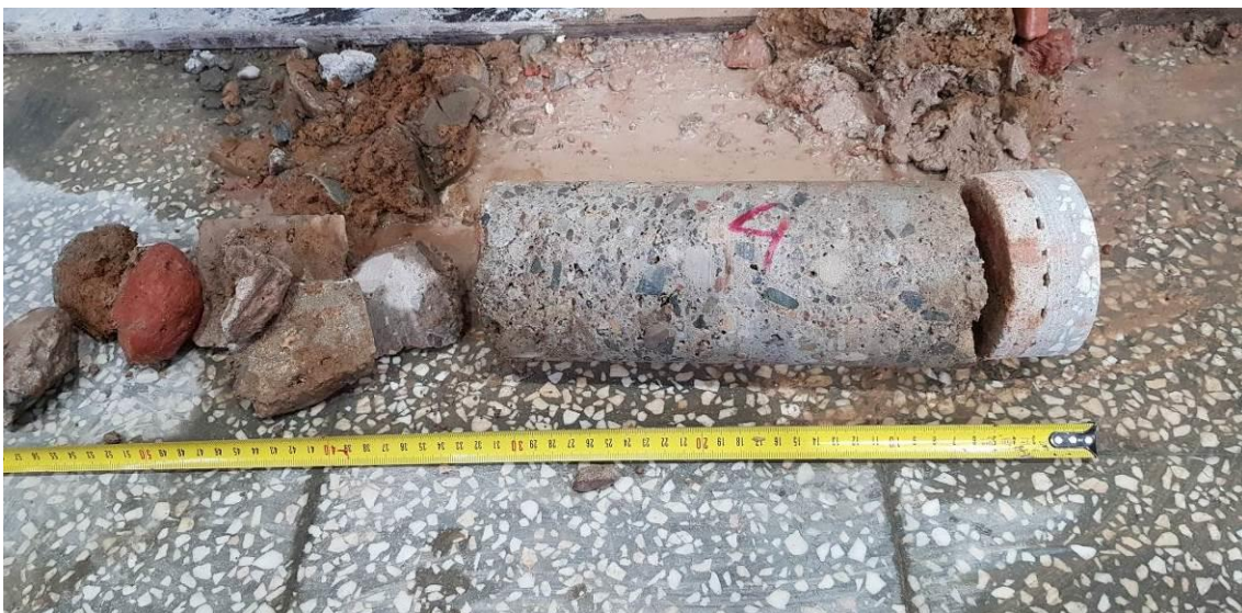
Fot. 8. Widok rdzenia dla przewiertu posadzki w lokalizacji nr 4a.
