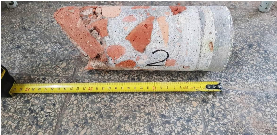
Fot. 6. Widok rdzenia dla przewiertu posadzki w lokalizacji nr 2.
