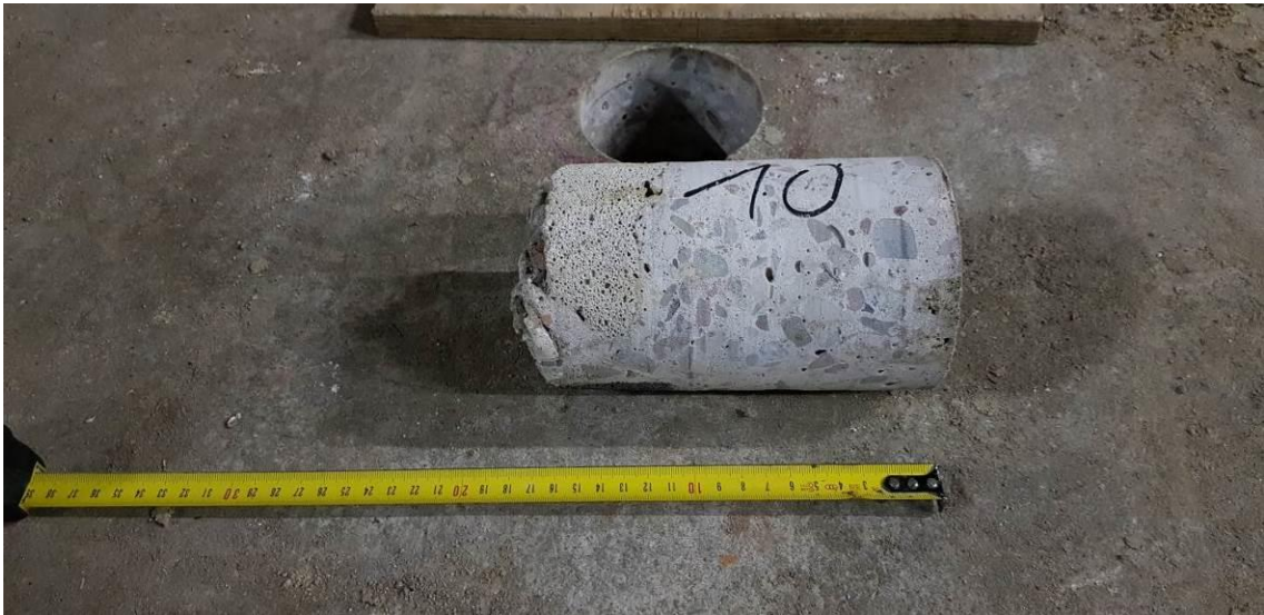
Fot. 15. Widok rdzenia dla przewiertu posadzki w lokalizacji nr 10.
