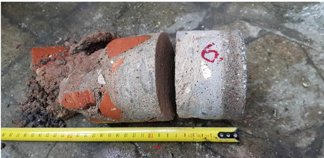
Fot. 11. Widok rdzenia dla przewiertu posadzki w lokalizacji nr 6.
