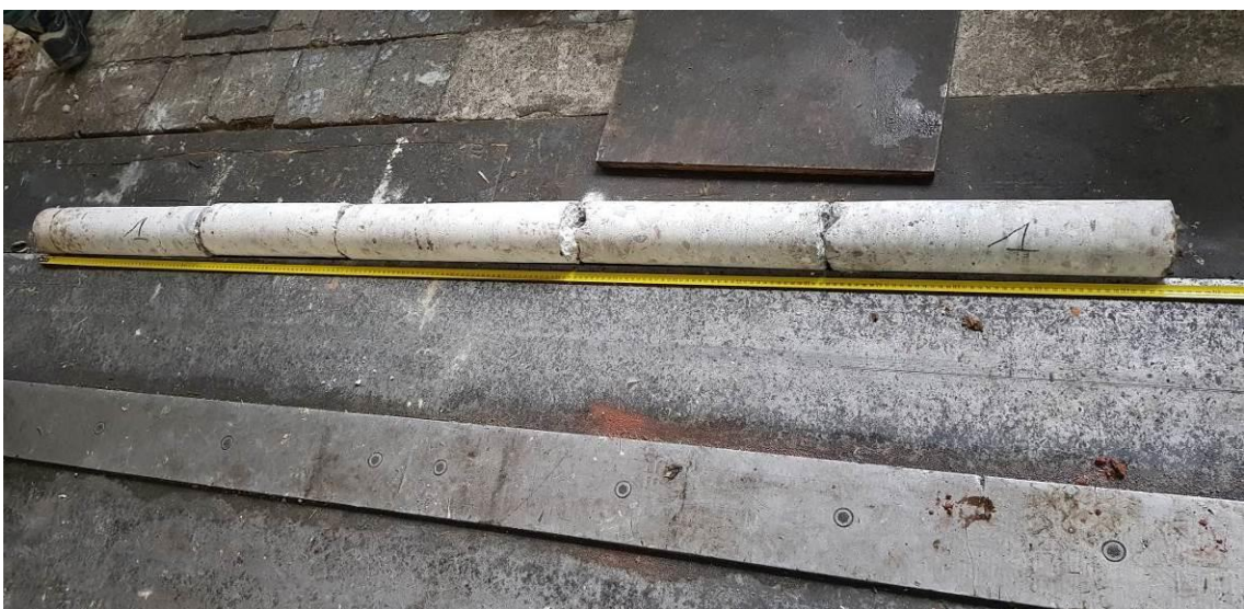
Fot. 5. Widok pełnego rdzenia przewiertu dla punktu w lokalizacji nr 1 – posadzka z fundamentem pod maszyny.
