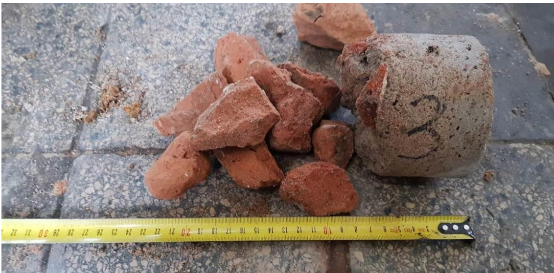
Fot. 7. Widok rdzenia dla przewiertu posadzki w lokalizacji nr 3.
