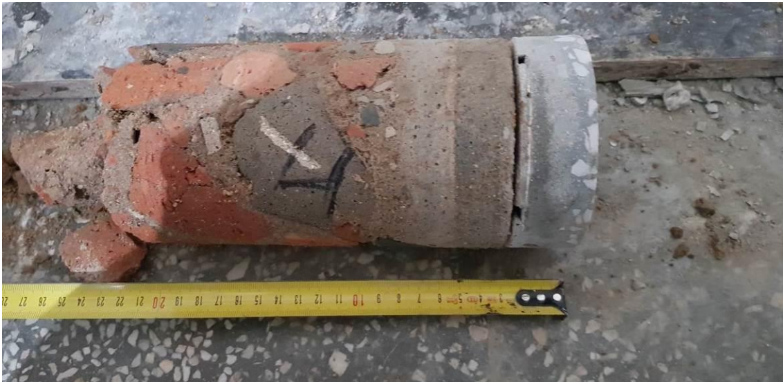
Fot. 9. Widok rdzenia dla przewiertu posadzki w lokalizacji nr 4b.
