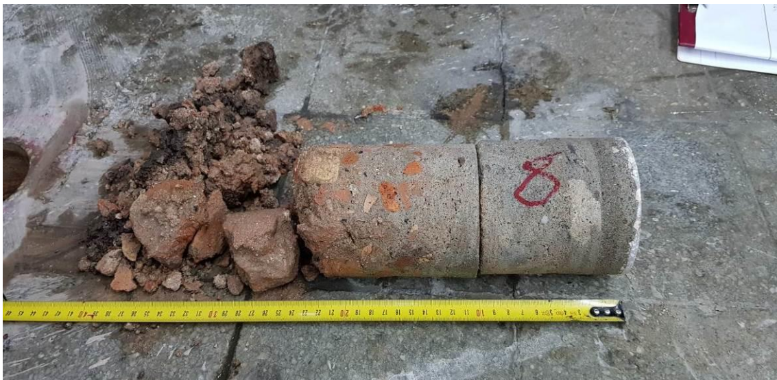
Fot. 13. Widok rdzenia dla przewiertu posadzki w lokalizacji nr 8.
