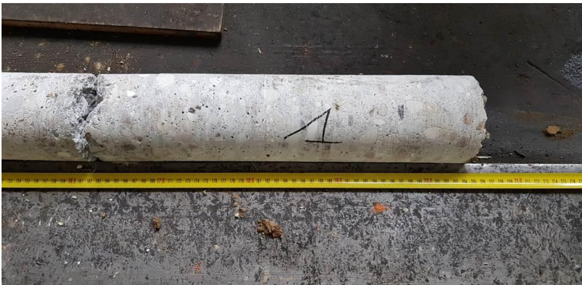
Fot. 4. Widok rdzenia dla przewiertu w lokalizacji nr 1 – dolna część rdzenia fundamentu.
