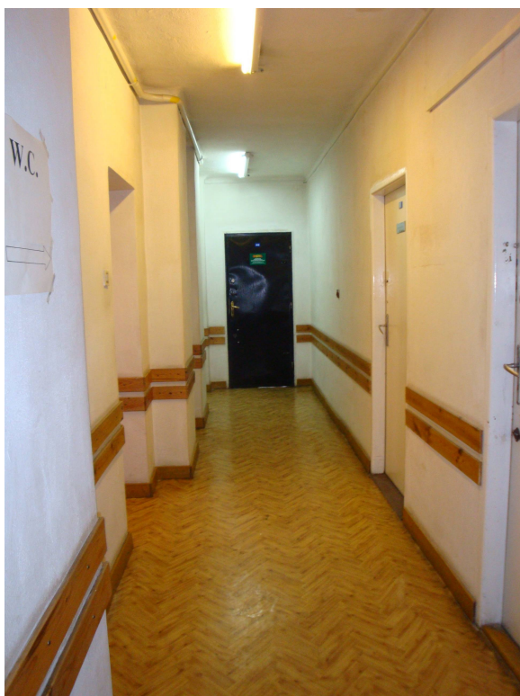
Korytarz parteru z wykładziną PCV na posadzce, odbojami drewnianymi na ścianach.
