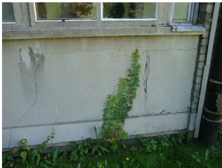
Miejscowe pęknięcia tynku w narożniku północno-zachodnim
