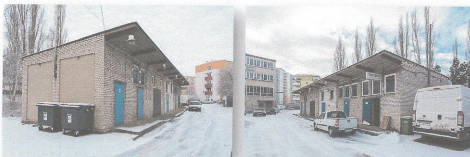
Widok na budynek magazynowy
