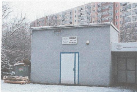
Widok na budynek magazynu z acetylenownią
