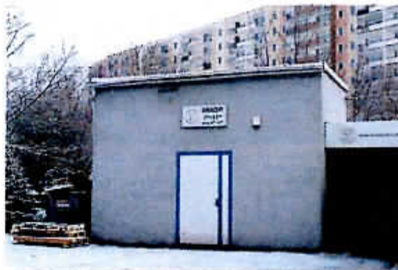
Widok na budynek magazynu z acetylenownią
