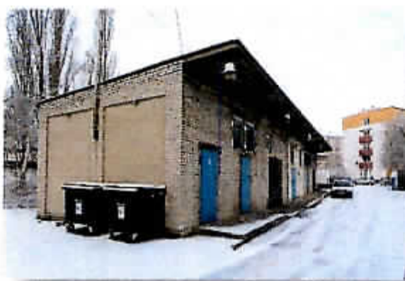
Widok na budynek magazynowy
