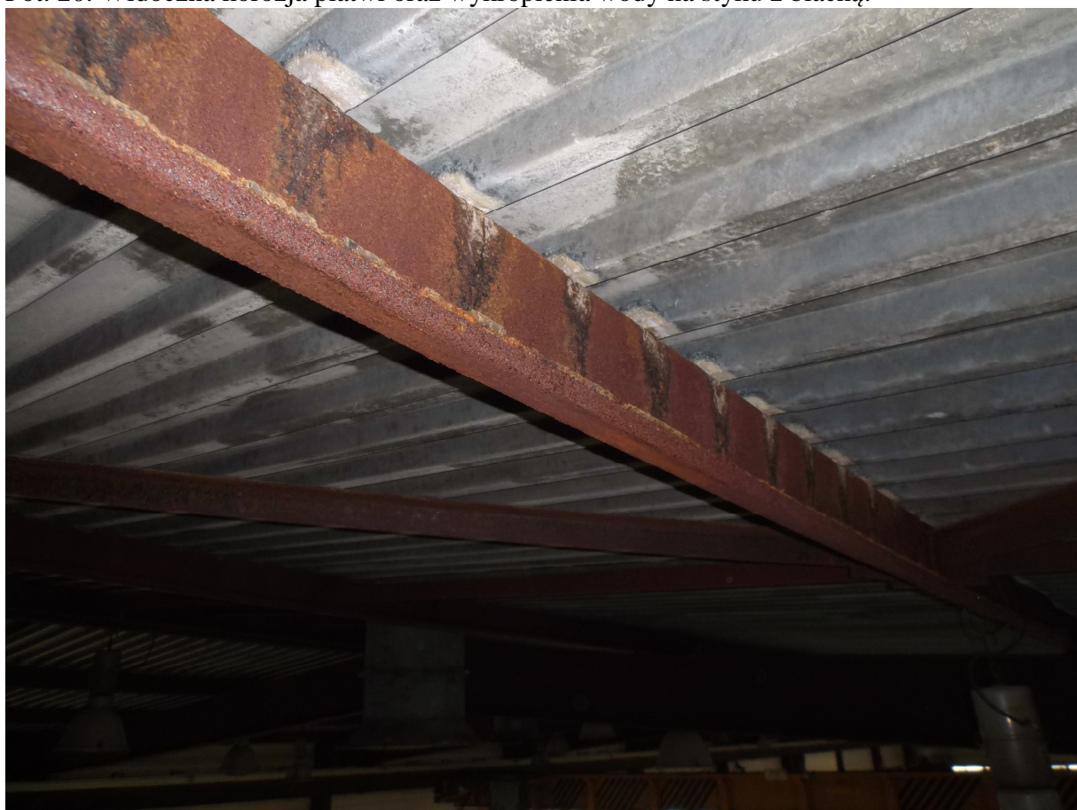
Fot. 20. Widoczna korozja płatwi oraz wykroplenia wody na styku z blachą.
