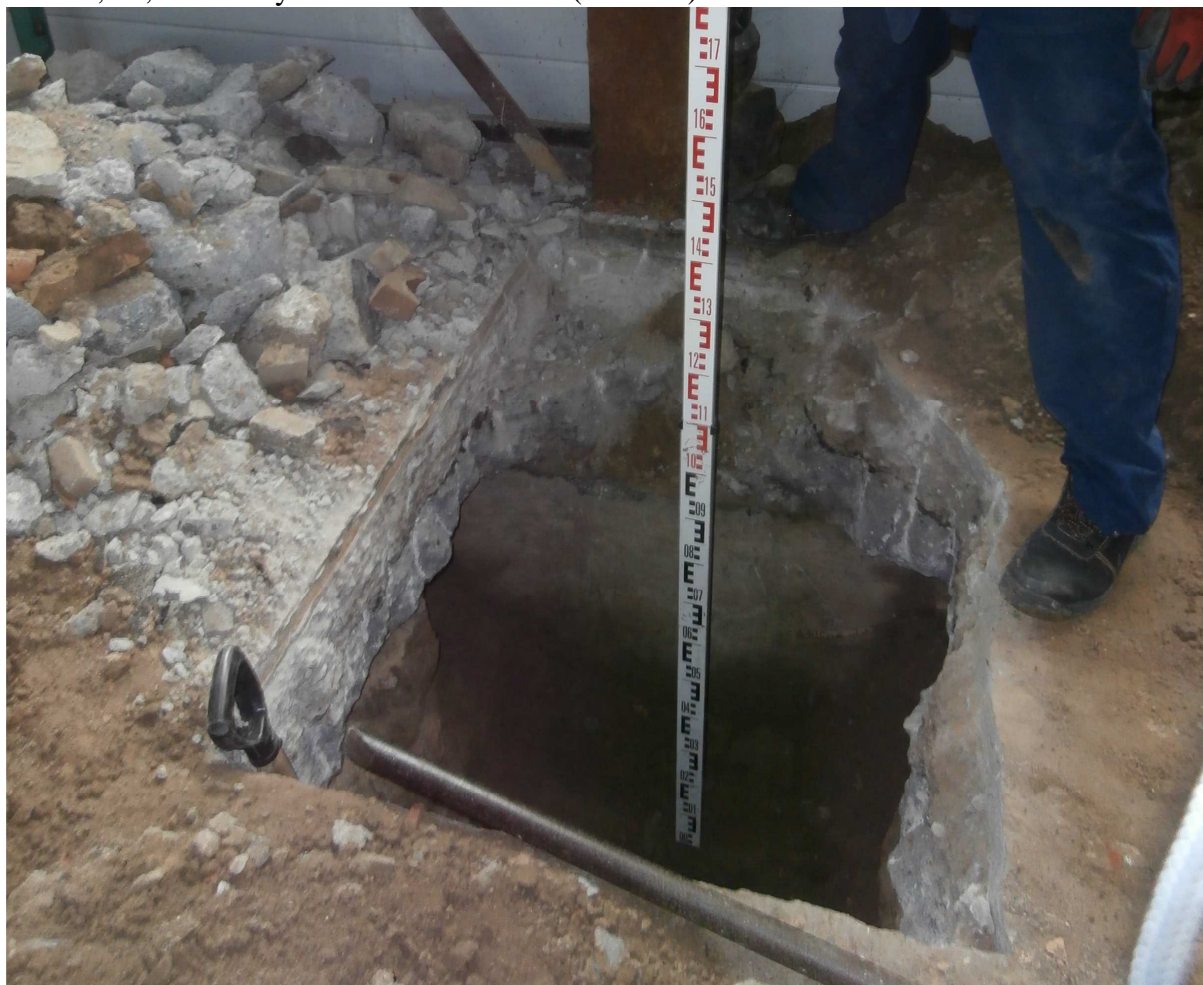
Fot. 23, 24, 25. Odkrywka fundamentu nr 2 (osie E-9).
