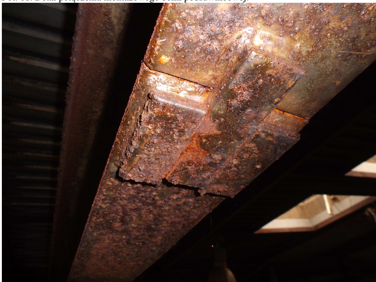
Fot. 18. Detal połączenia montażowego belki podsownicowej.
