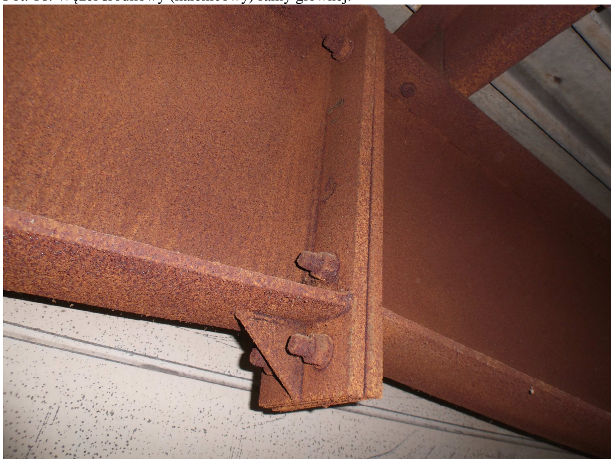
Fot. 16. Węzeł środkowy (kalenicowy) ramy głównej.
