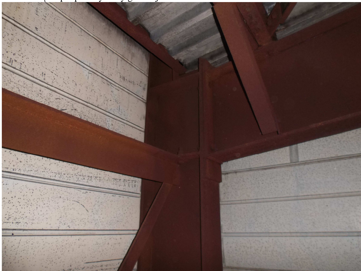
Fot. 16. Węzeł środkowy (kalenicowy) ramy głównej.
