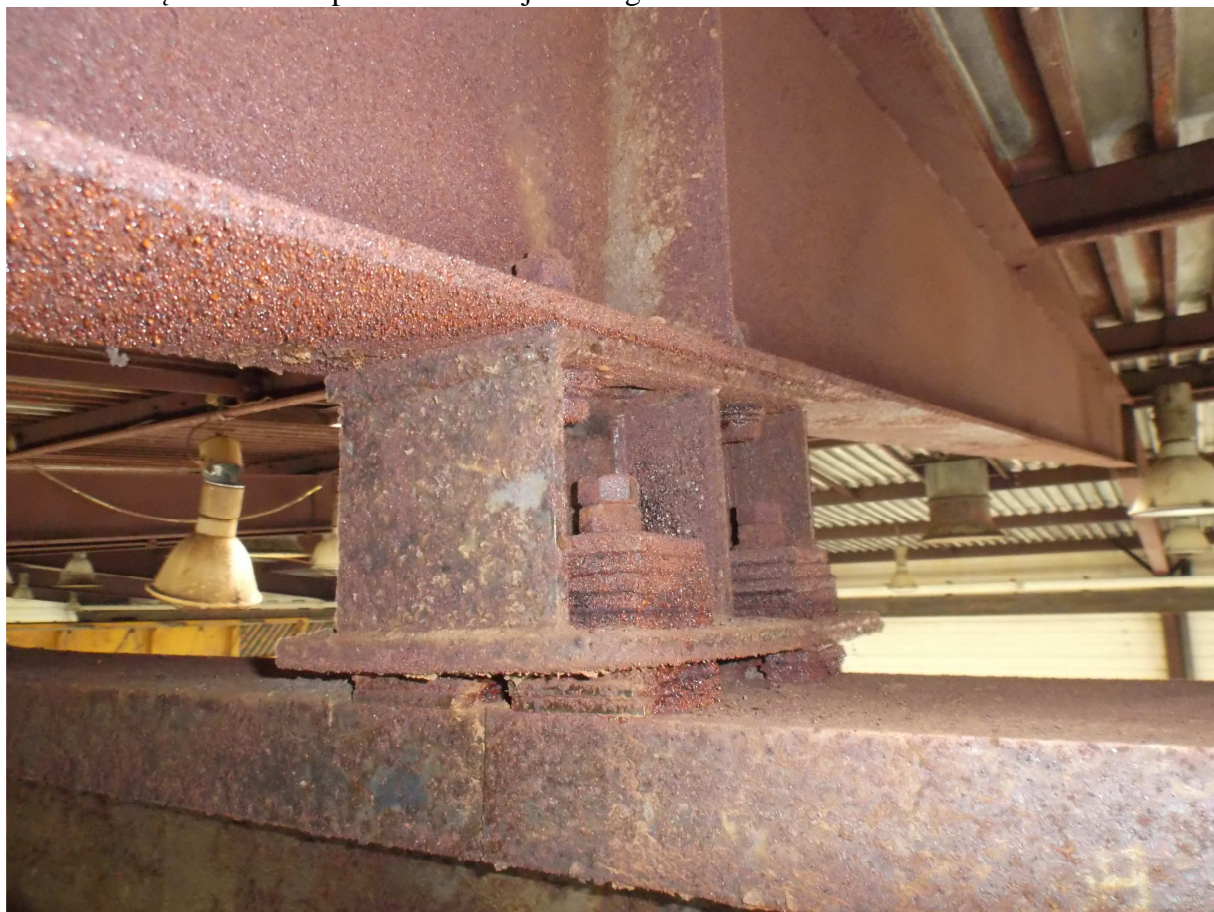
Fot. 18. Detal połączenia montażowego belki podsownicowej.
