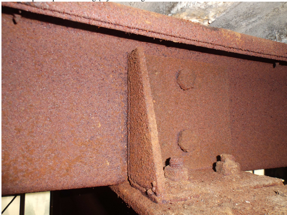
Fot. 20. Widoczna korozja płatwi oraz wykroplenia wody na styku z blachą.
