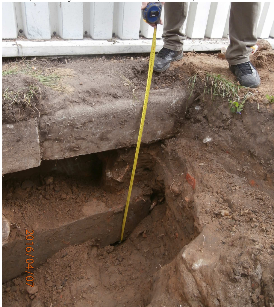
Fot. 21, 22. Odkrywka fundamentu nr 1 (osie A-2).
