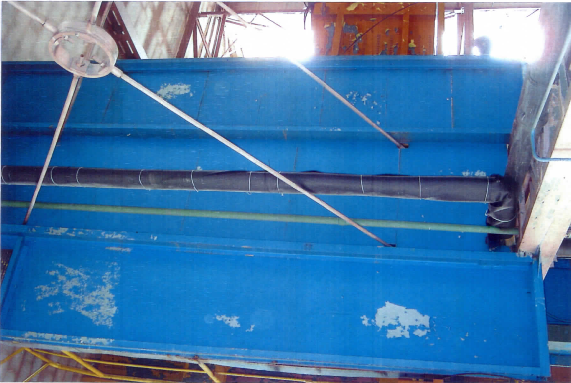
Rys 25 Stężenie pionowe hali 1.
