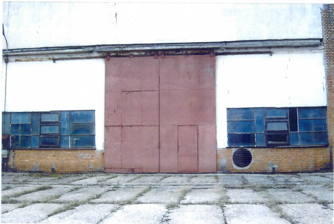
Rys 8 Widok zewnętrznej ściany wschodniej hali 1.
