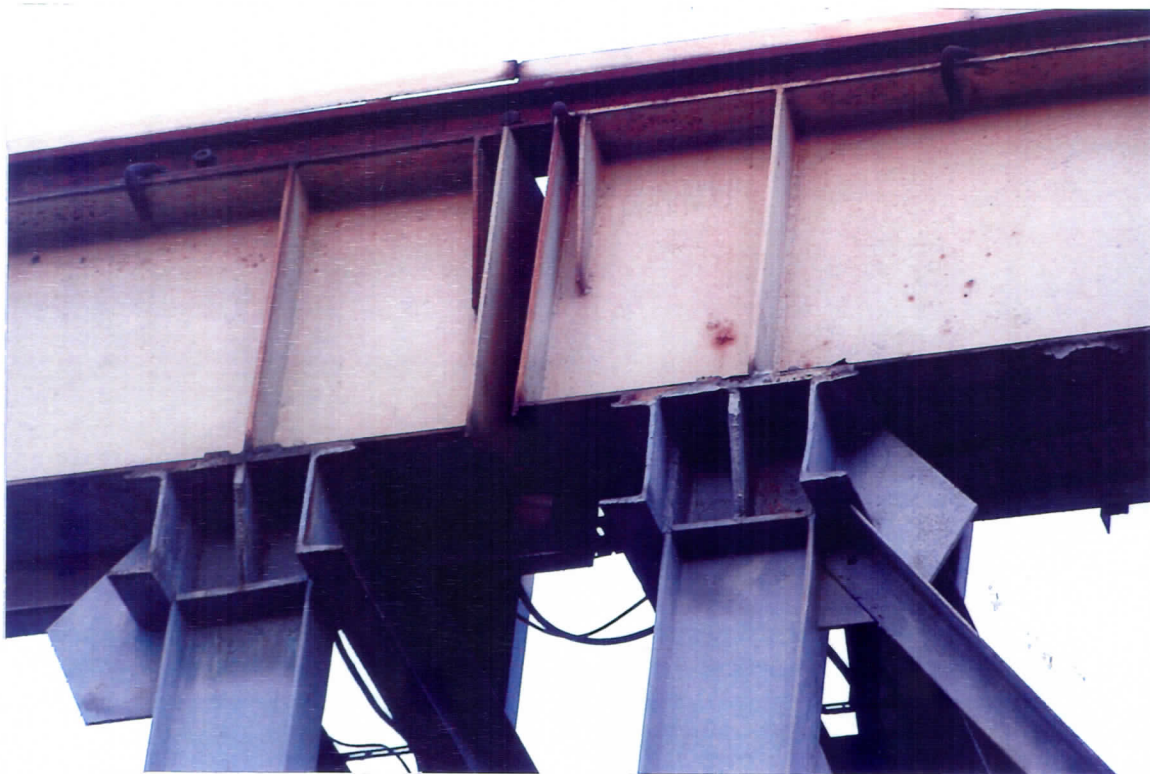
Rys 45 Szczegół dylatacji belki podsuwnicowej na estakadzie.
