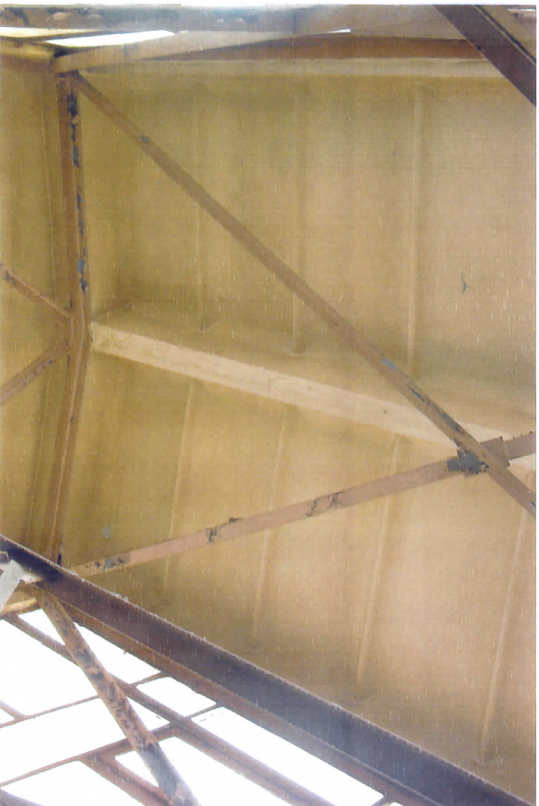
Rys 22 Stężenia połaciowe hali 1.
