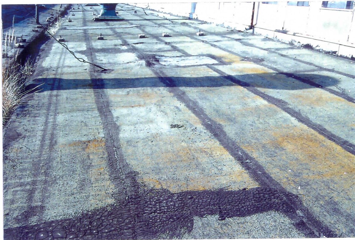
Rys 11 Widok pokrycia dachu hali 1.
