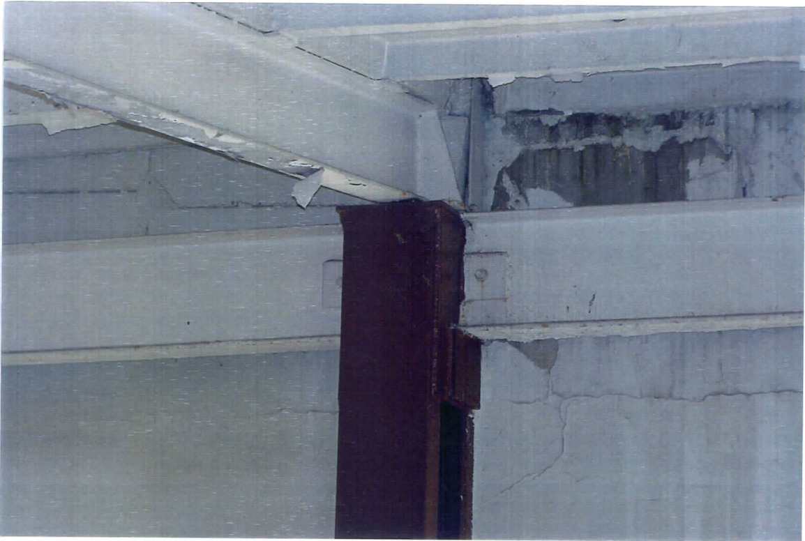
Rys 19 Podparcie podciągów dachowych Hali 2 w osi 1.
