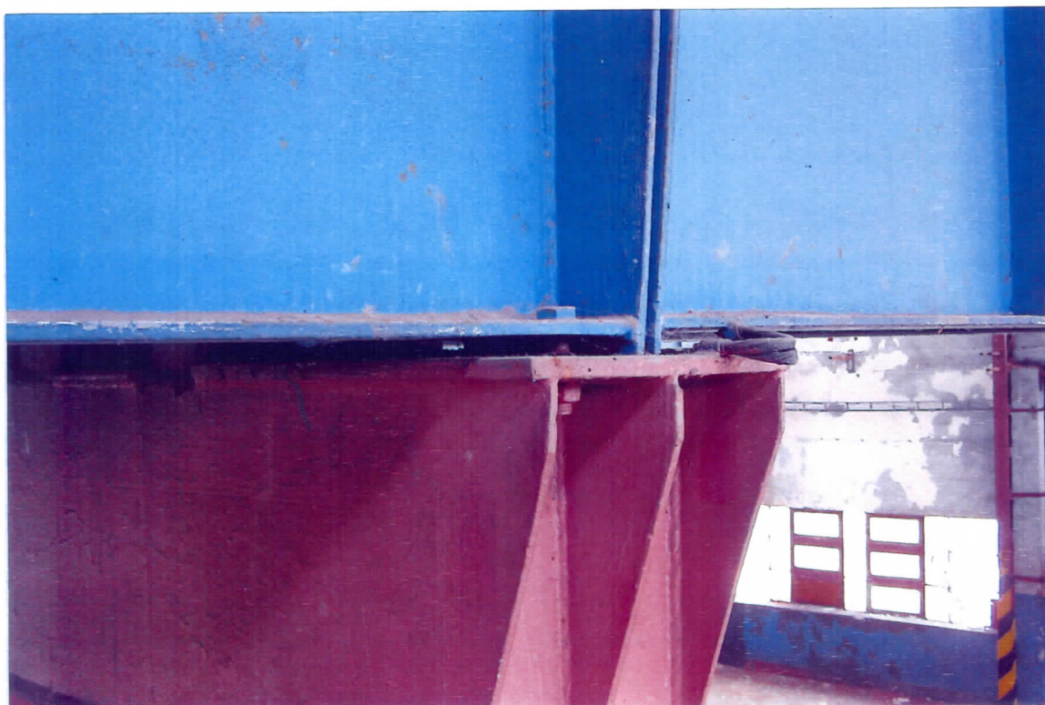
Rys 46 Szczegół podparcia belki podsuwnicowej na estakadzie.
