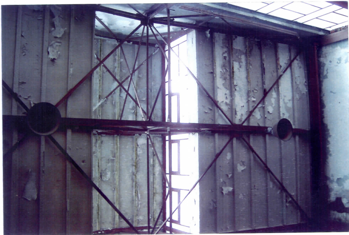
Rys 26 Stężenia pionowe hali 1.
