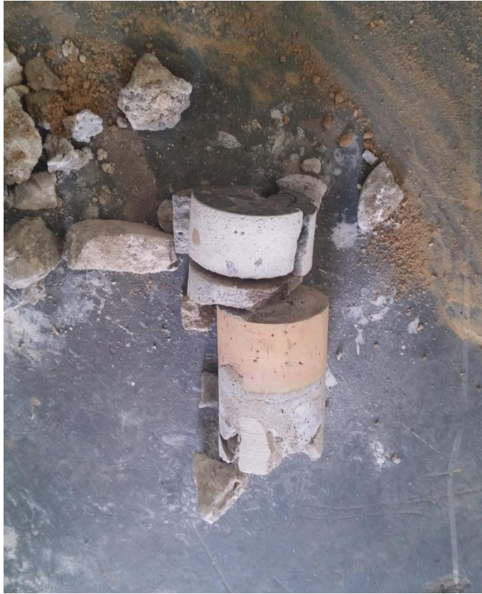
Fot. 3. Widok rdzenia w pkt. nr 3 – układ warstw konstrukcyjnych posadzki.
