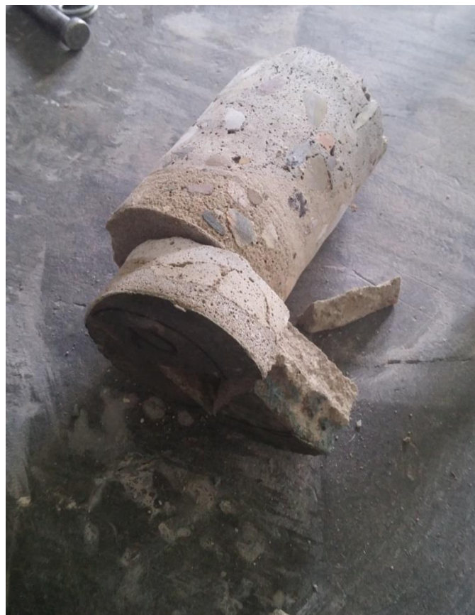
Fot. 2. Widok rdzenia w pkt. nr 2 – układ warstw konstrukcyjnych posadzki.
