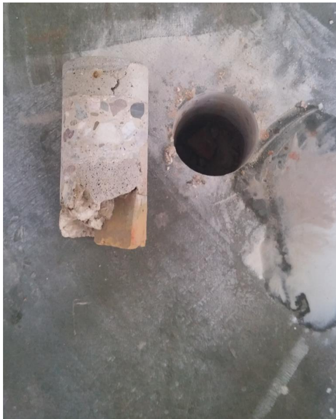
Fot. 4 Widok rdzenia w pkt. nr 4 – układ warstw konstrukcyjnych posadzki.
