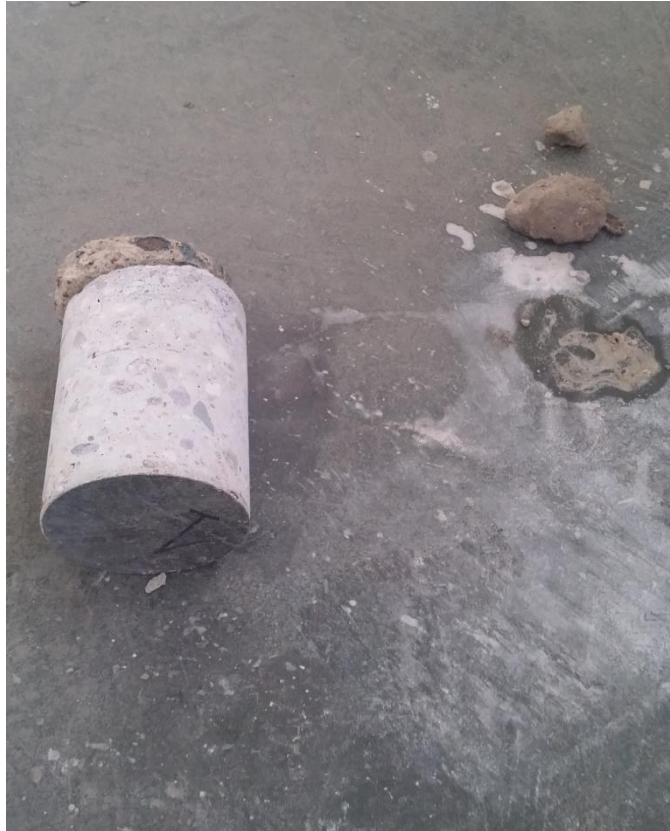
Fot. 1. Widok rdzenia w pkt. nr 1 – układ warstw konstrukcyjnych posadzki.
