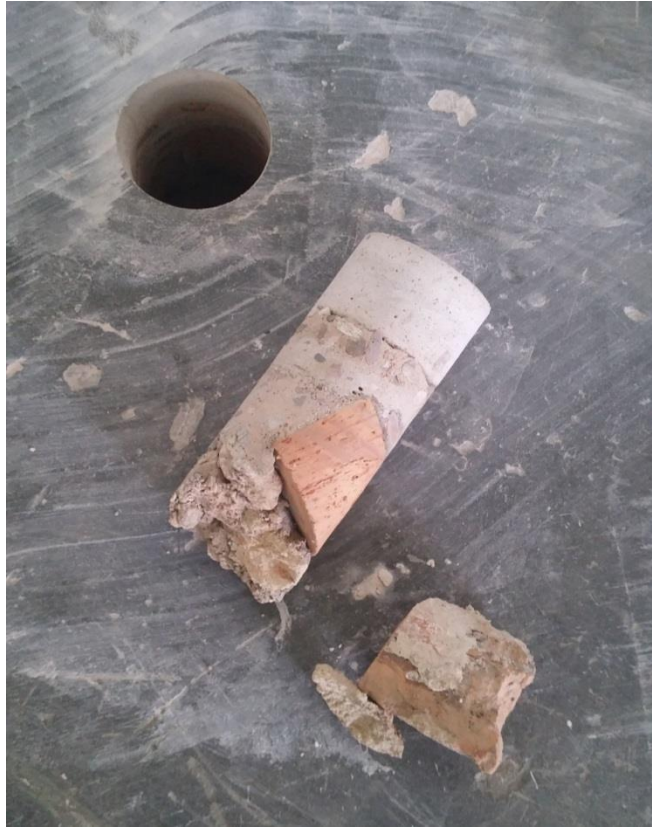
Fot. 5 Widok rdzenia w pkt. nr 5 – układ warstw konstrukcyjnych posadzki.
