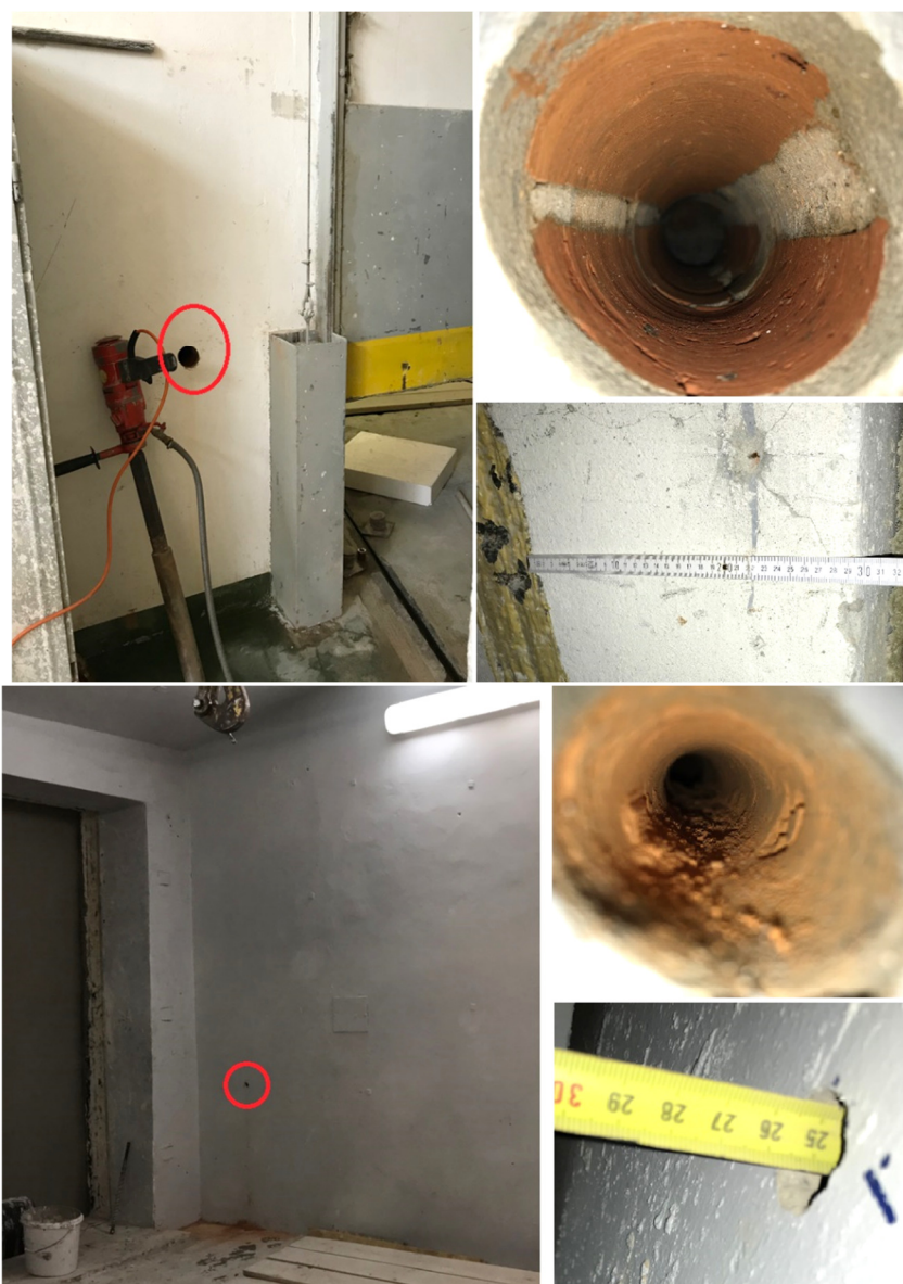
Fot. nr 2. Przykłady odkrywek/odwiertów w ścianach murowanych pomieszczenia badawczego (źródło: [2, 3])
