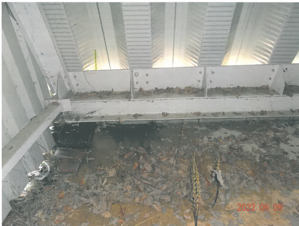
Widok połączenia konstrukcji stalowej powłokowo- łukowej z wieńcem stalowym oraz ryglami ściany szczytowej
