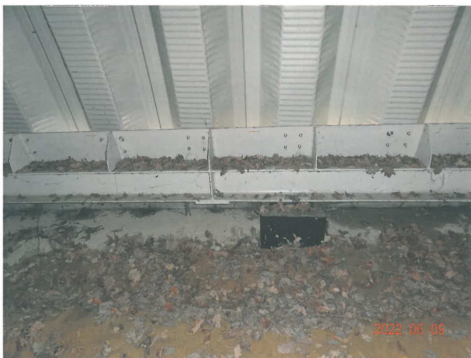
Widok połączenia konstrukcji stalowej powłokowo- łukowej z wieńcem stalowym
