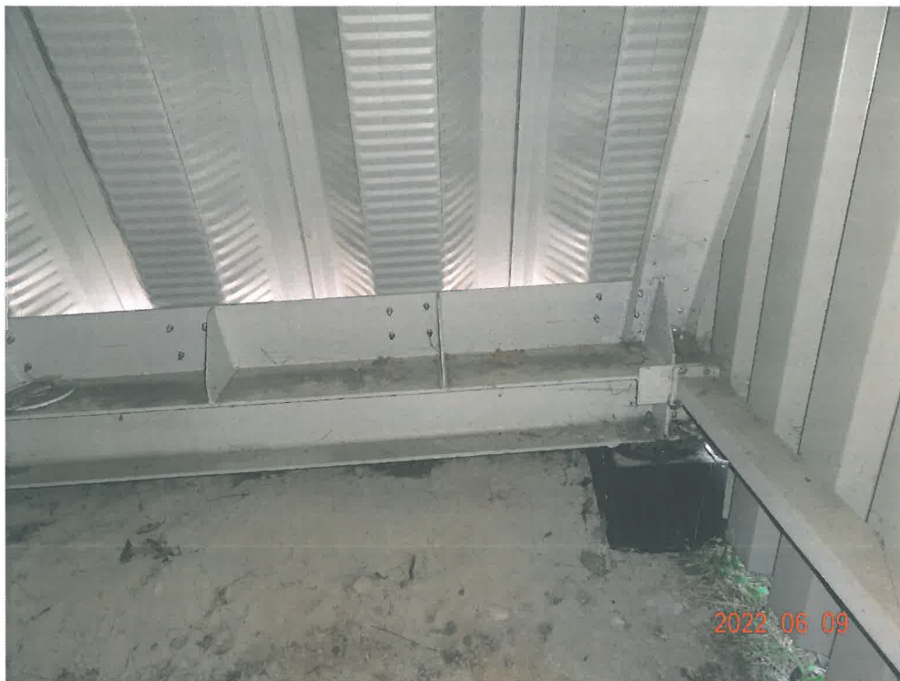
Widok połączenia konstrukcji stalowej powłokowo- łukowej z wieńcami stalowymi oraz ryglami ściany szczytowej
