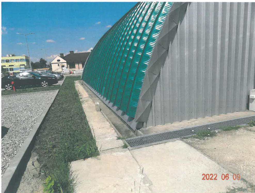
Widok hali łukowej od strony południowo- zachodniej wraz z korytem odwadniającym
