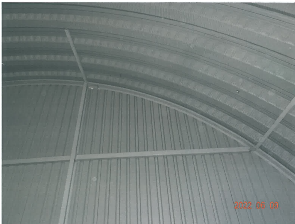
Widok połączenia ściany szczytowej z konstrukcją stalową powłokowo- łukową
