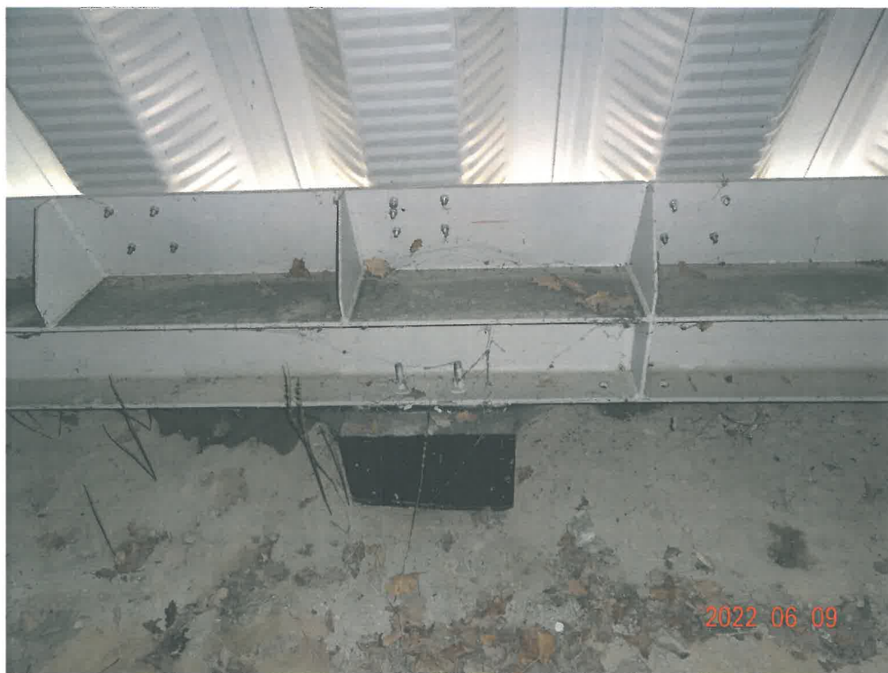
Widok połączenia konstrukcji stalowej powłokowo- łukowej z wieńcami stalowymi
