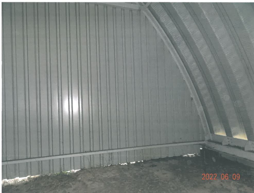
Widok połączenia ściany szczytowej z konstrukcją stalową powłokowo- łukową
