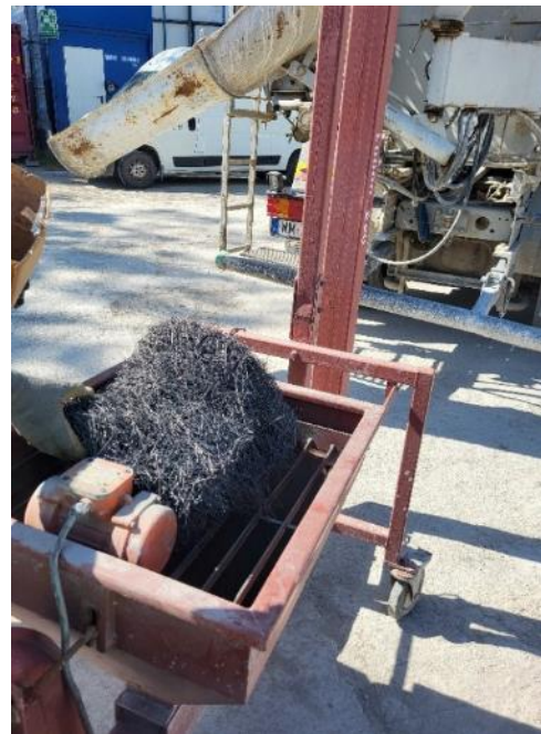
Fot 86. Dozowanie włókien MSF do betonowozu
