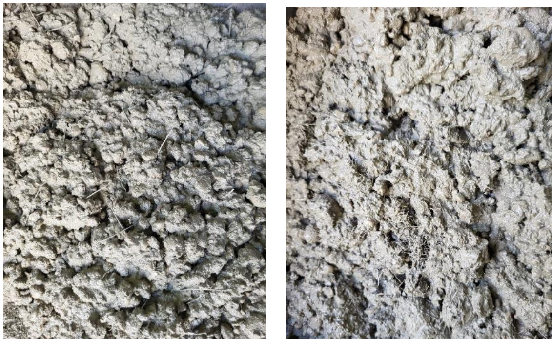
a) b) Fot 90. Mieszanka betonowa z włóknami, a) MSF, b) RTSF
