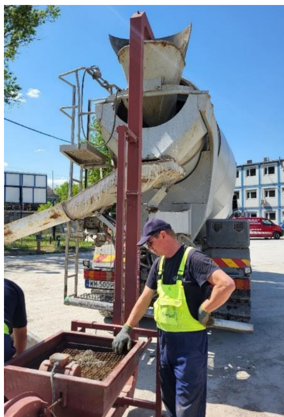
Fot 89. Sposób dozowania włókien RTSF za pomocą dostosowanego systemu dozowania
