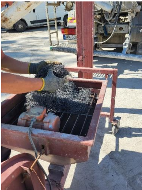
Fot 86. Dozowanie włókien MSF do betonowozu
