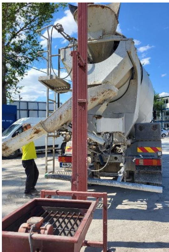
Fot 87. System dozujący włókna stalowe do betonowozu
