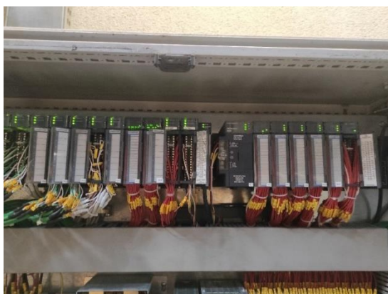
Rys. 8 Sterownika logicznego szafy F3' i F3''.
