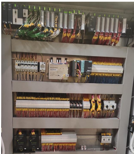
Rys. 6 Rzeczywisty wygląd szafy sterowniczej F3' i F3''.
