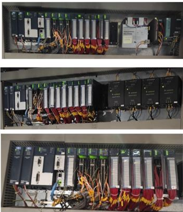
Rys. 2 Rzeczywisty wygląd elementów odpowiadających za sterowanie automatyką pieca F1.
