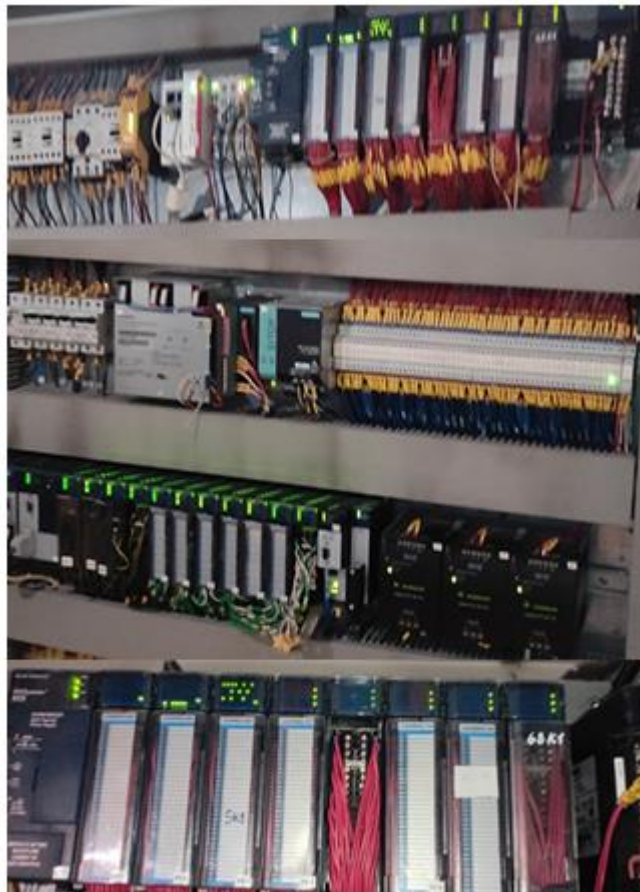
Rys. 4 Rzeczywisty wygląd szafy sterowniczej F3.
