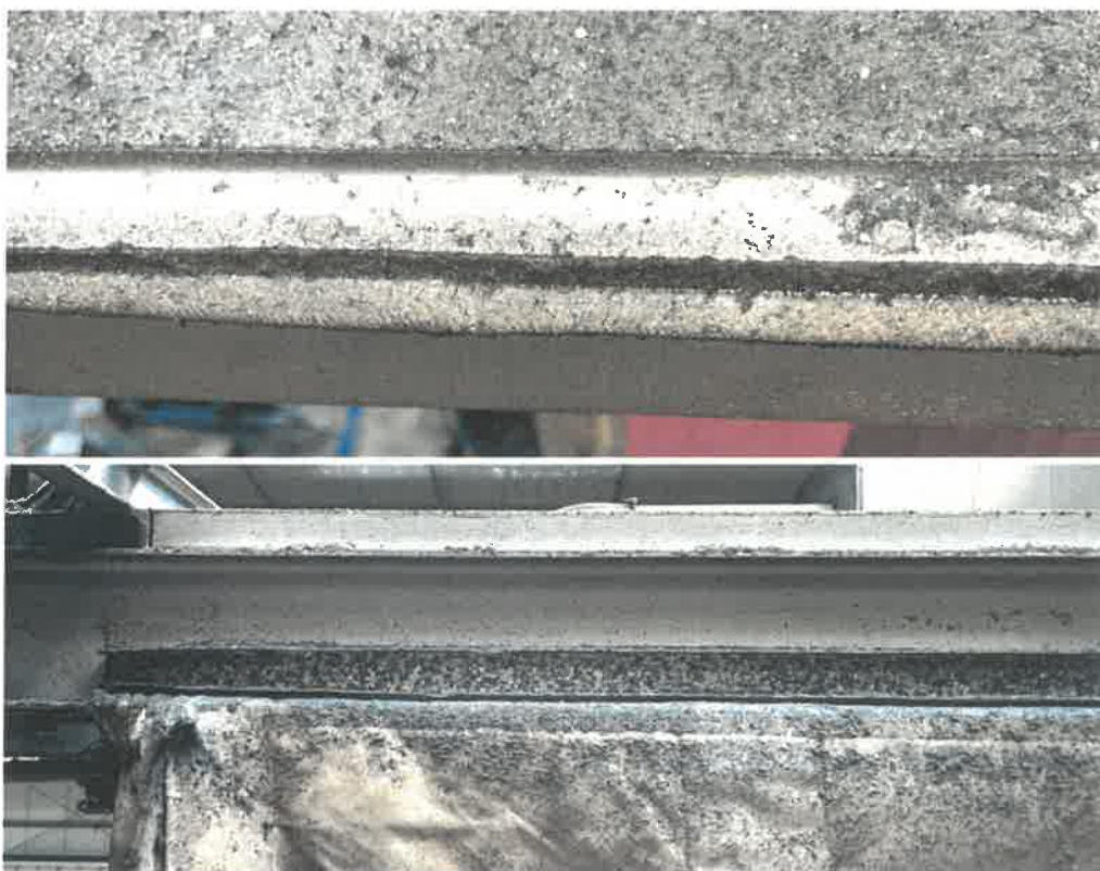
Mocowanie tkaniny do podkonstrukcji stalowej za pomocą ceowników śrub i wkrętów
